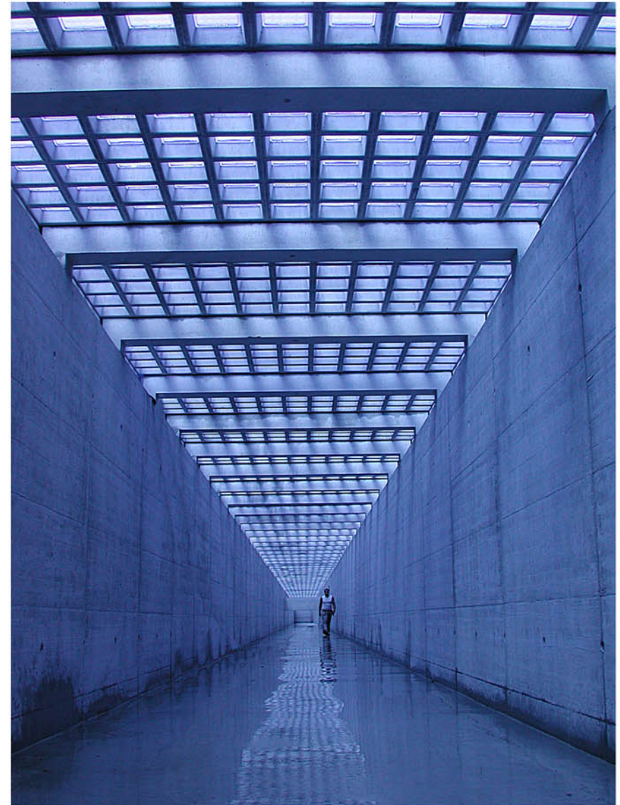
Der blaue Glasbalken - Innenraum, Baustelle 4 Mai 05
